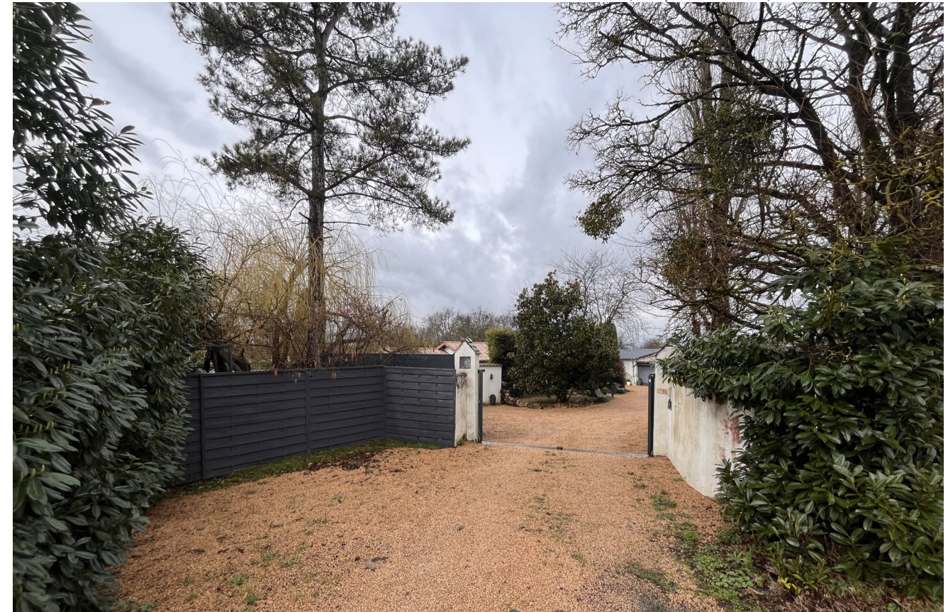
Vue 1. Vue sur le bâti, depuis l'accès, en limite de voirie
