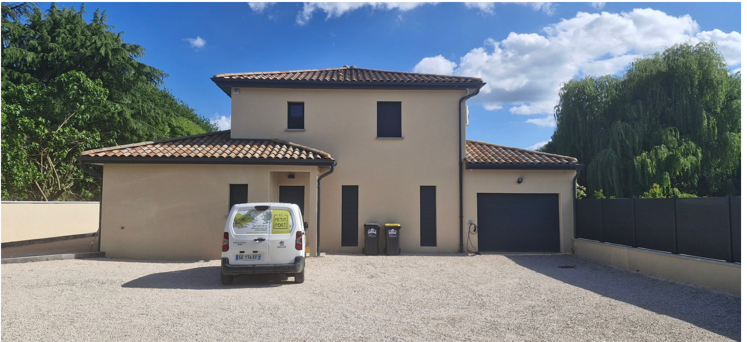
Vue sur toiture NORD
